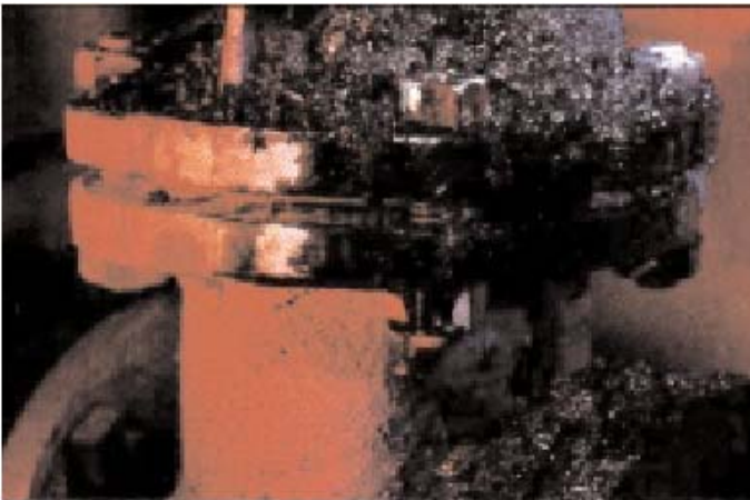
Использование теплоносителя с повышенным давлением паров может привести к значительным накоплениям нагара на регулировочных клапанах и фланцах труб.
